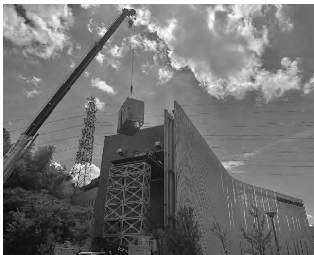
図 67: 工事中のトランス搬入作業の様子
