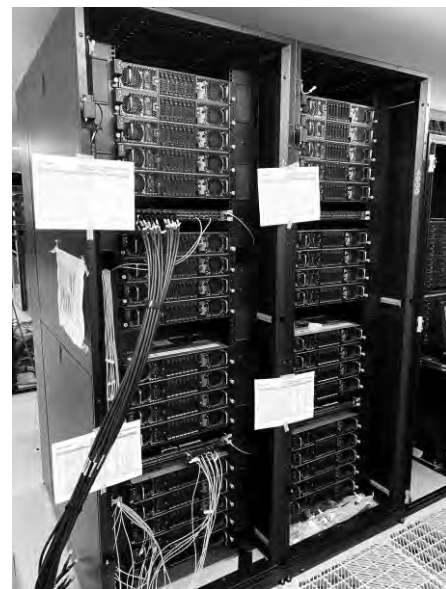
図 48: 搬入・設置されたベクトルノード (3 月 5 日頃)
