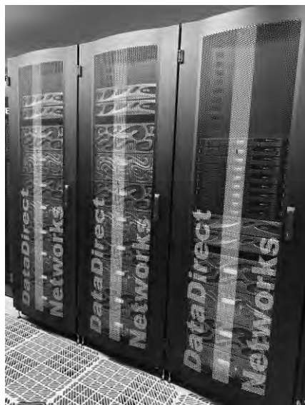
図 51: 搬入・設置されたストレージ (3 月 5 日頃)
